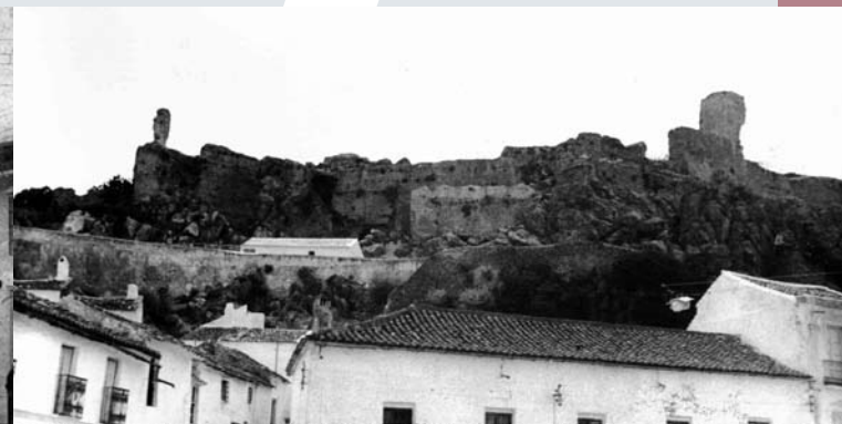
CAÑETE LA REAL. Castillo (1961). Archivo Fotográfico Juan Temboury, R. 971a.
